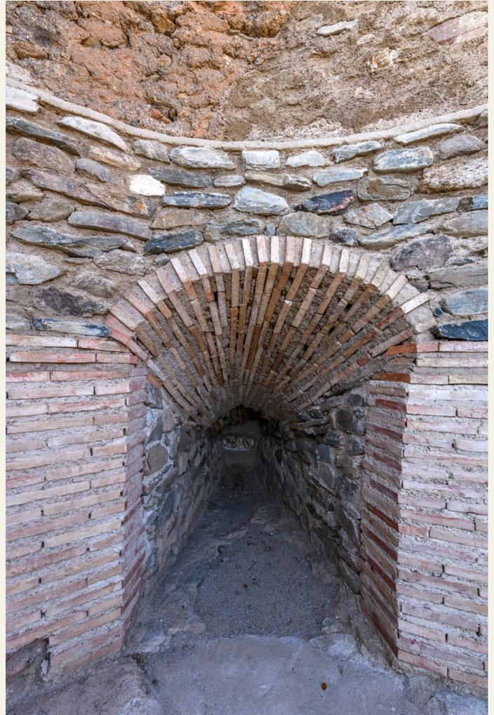
La technique de construction employée est la maçonnerie de concert, utilisée aussi bien dans les constructions ex novo que dans les différentes réparations.
